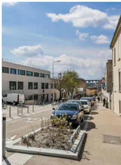
La rue Cauchy réaménagée à Arcueil
